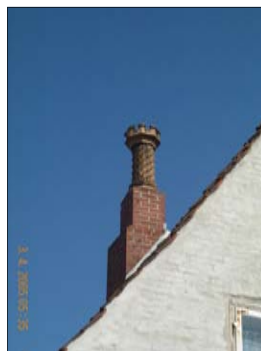
Drejet skorstenspipe på kakkellovnsmagerens ejendom
